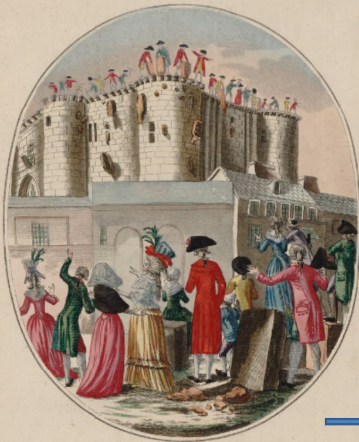
DEMOLITION DE LA BASTILLE
